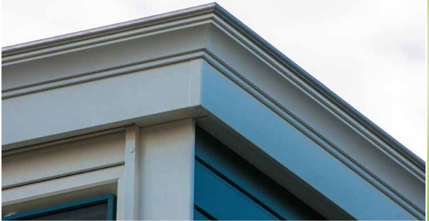
Dakrandafwerking ronde kraal i.c.m. neuslijst
