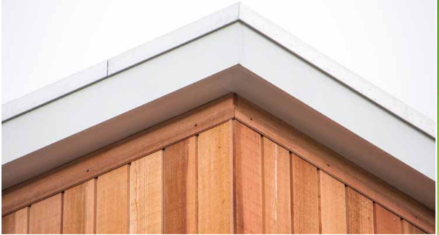
Dakrandafwerking ronde kraal i.c.m. neuslijst
